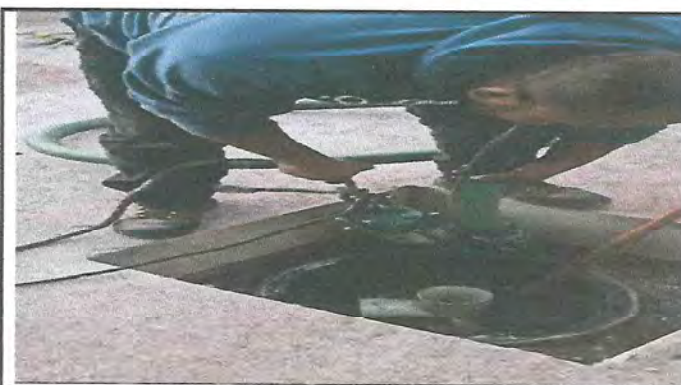
Foto 4: LIMPIEZA DE LA FOSA SEPTICA
