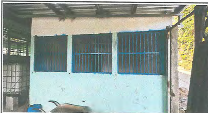
Foto 3: SUSTITUCION DE BALCONES
