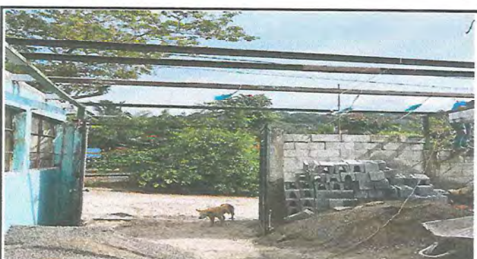
Foto 4: REMOZAMIENTO DE PORTON
