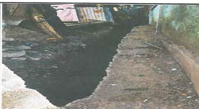
Foto 4: LEVANTADO DE MURO
