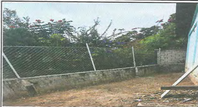
Foto1: INSTALACION DE MALLA METALICA
