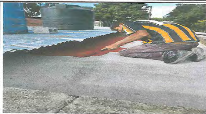
Foto1: IMPERMEABILIZACION DE BAÑO
