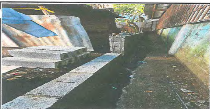
Foto 5: LEVANTADO DE MURO
