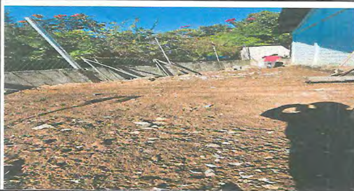
Foto1: NIVELACION PARA LA FUNDICIÓN DE LOSA DE PATIO
