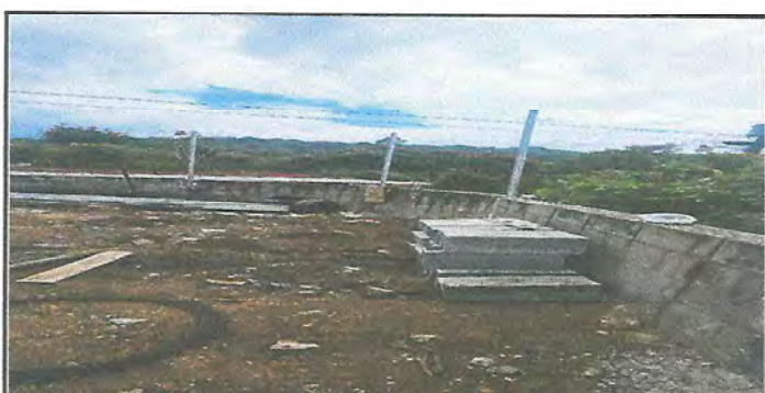
Foto 6: INSTALACION DE MALLA METALICA
