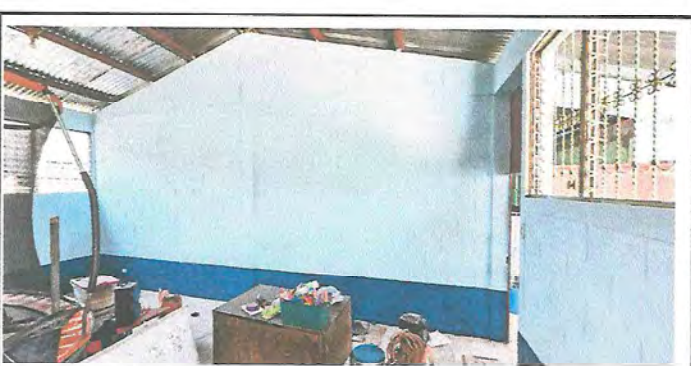
Foto 6: APLICACION DE PINTURA GENERAL
