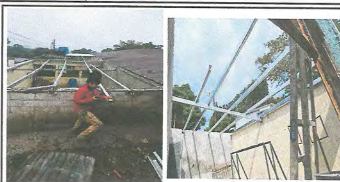
Foto 2: REMOZAMIENTO DE TECHO DE COCINA
