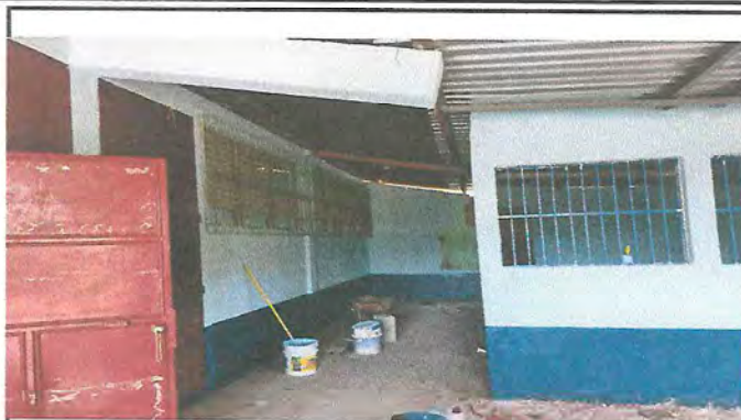
Foto 2: APLICACIÓN DE PINTURA GENERAL
