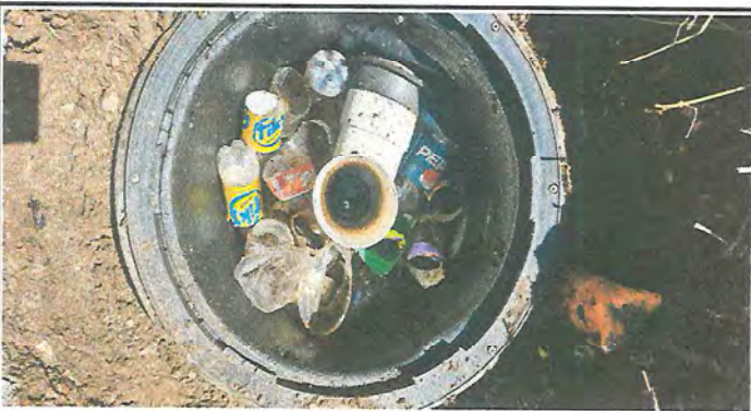
Foto 3: LIMPIEZA DE LA FOSA SEPTICA
