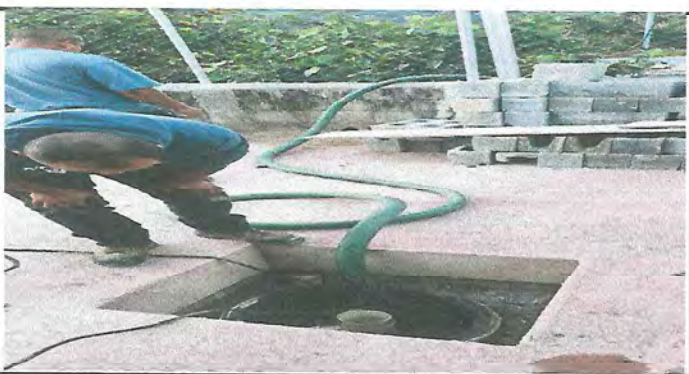
Foto 5: LIMPIEZA DE LA FOSA SEPTICA
