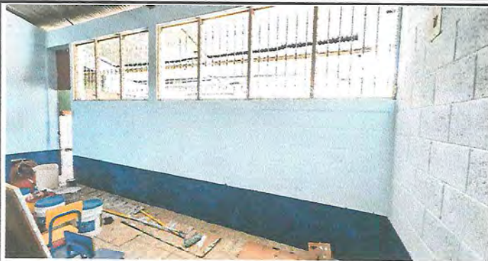
Foto1: APLICACIÓN DE PINTURA GENERAL
