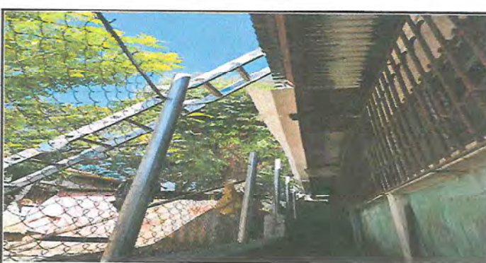
Foto 6: INSTALACION DE CANAL COLONIAL
