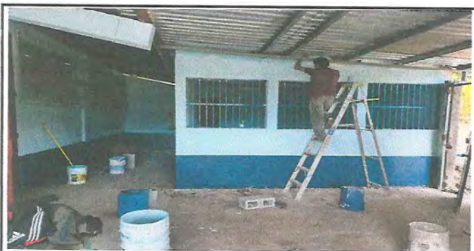
Foto 5: APLICACIÓN DE PINTURA GENERAL
