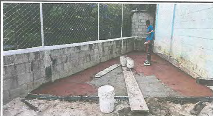
Foto 2: FUNDICIÓN DE LOSA DE PATIO
