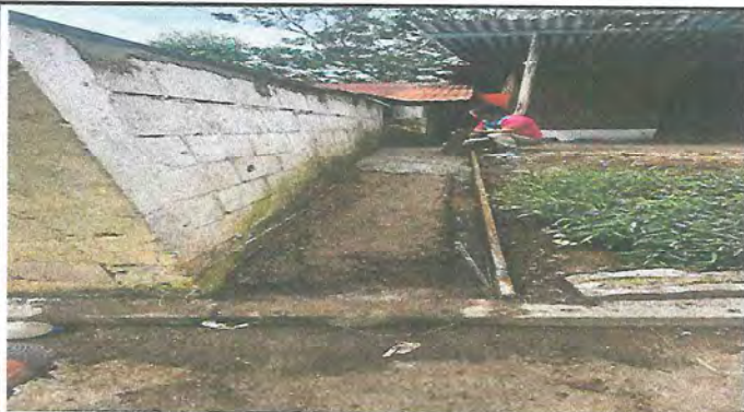
Foto 3: FUNDICION DE BANQUETA
