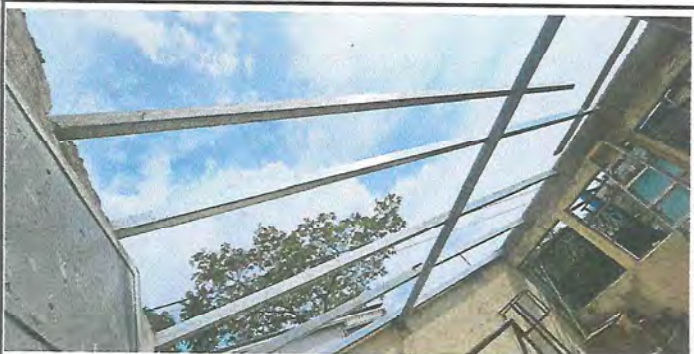
Foto 3: REMOZAMIENTO DE TECHO DE COCINA
